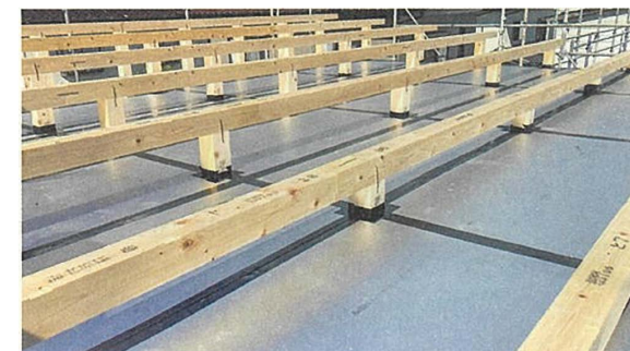
アキレス・キューワンボードによる桁上断熱の施工現場
