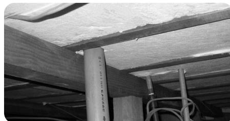
図9 配管等の貫通部の施工状況
