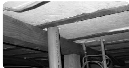
図9 配管等の貫通部の施工状況
