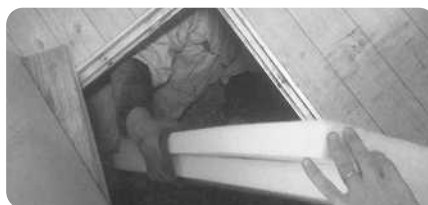
図3 床下収納庫からの材料搬入
